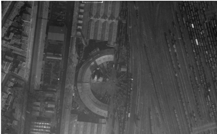
Vue 1922 - Rotonde et ateliers ferroviaires - ©EPA Euratlantique
